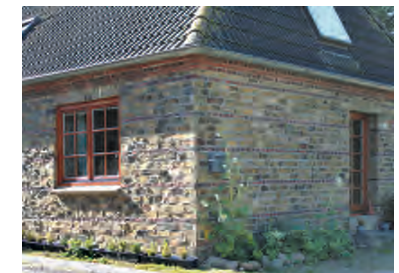
Gebäude aus Fehlbränden in Borgwedel
